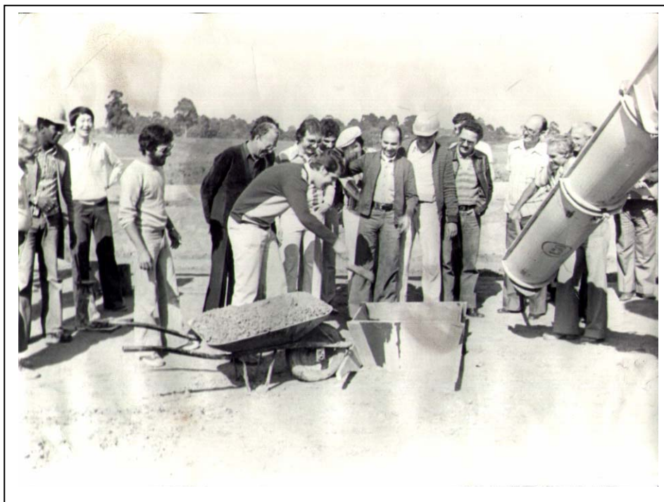
1978 - Engenheiros e arquitetos responsáveis pelo projeto acompanham o Diretor Engº Luiz Antonio Beldi Castanho no lançamento da pedra fundamental do prédio B.
