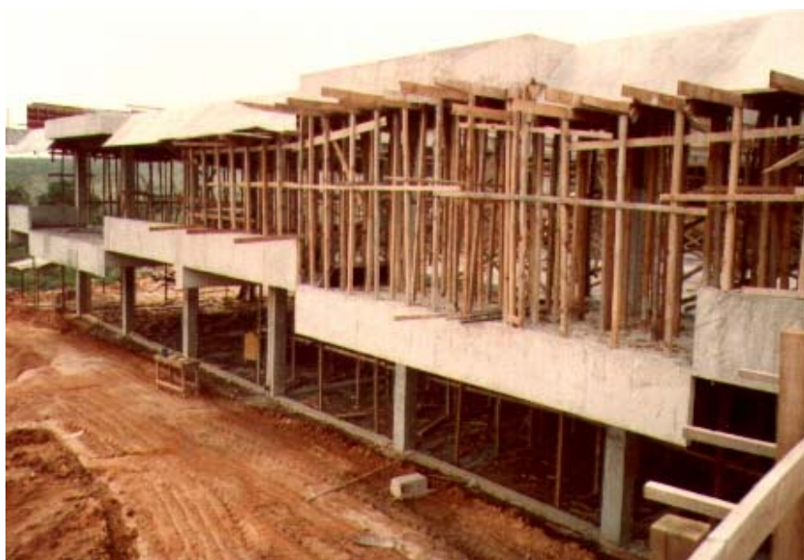
1979 - Registro fotográfico do andamento das obras de construção de um dos prédios da FACENS.
