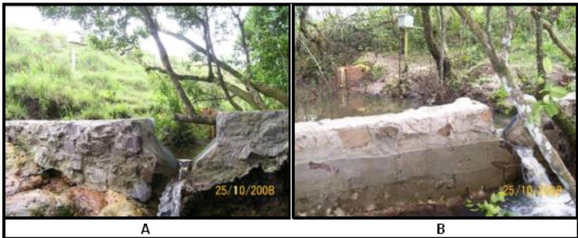
**Figura 5.10 – Estrutura hidráulica com poço tranqüilizador da microbacia de campo (A) e da microbacia florestada (B), sob as coordenadas 702968 E, 6643251 S e 704445 E, 6630250 S, respectivamente.**
