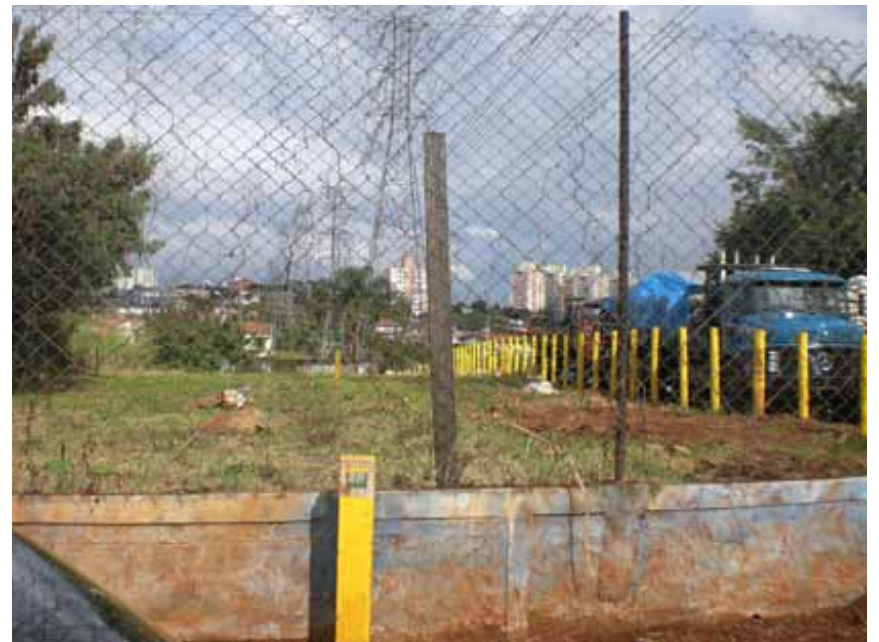
ÁREA PRÓXIMA À AV. POLITÉCNICA.
